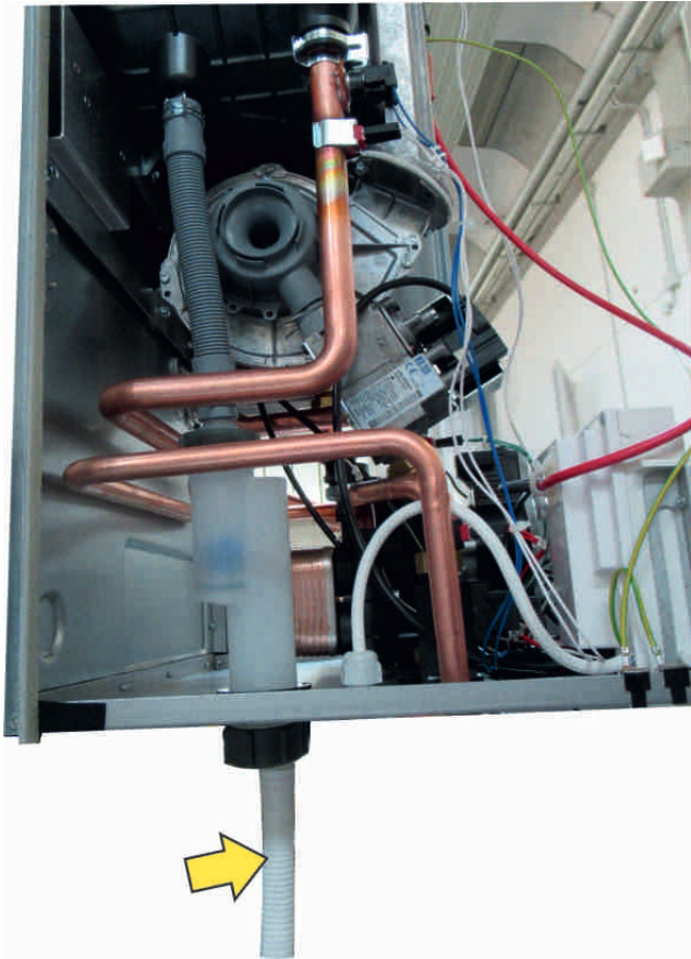
Uscita condensa, tubo da collegare allo scarico fognario
