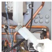
Rimozione sifone condensa
