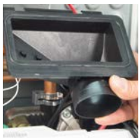
Ispezione raccolta condensa
