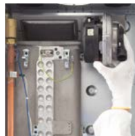
Rimozione del sistema di combustione completo
