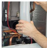
Rimozione collettore fumi
