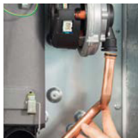
Rimozione del tubo gas
